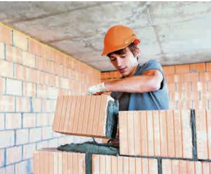
Für den Bau einer Backsteinmauer schöpft der Maurer Mörtel auf den Backstein und setzt diesen in die Mauer ein. Foto: Baumeisterverband
